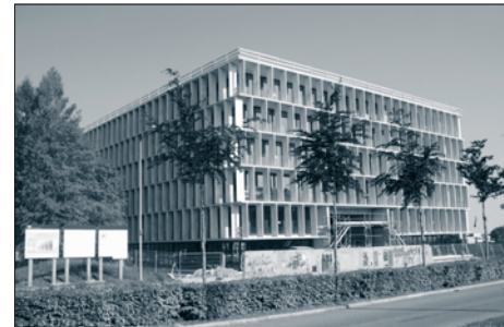
Das Forschungsgebäude «Sciencelab» steht im Rohbau fertig.
